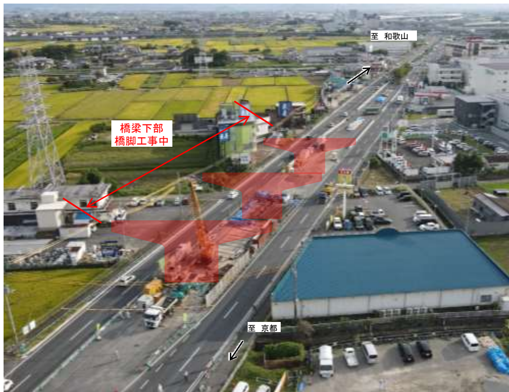
大和北道路(大和郡山市横田町)
